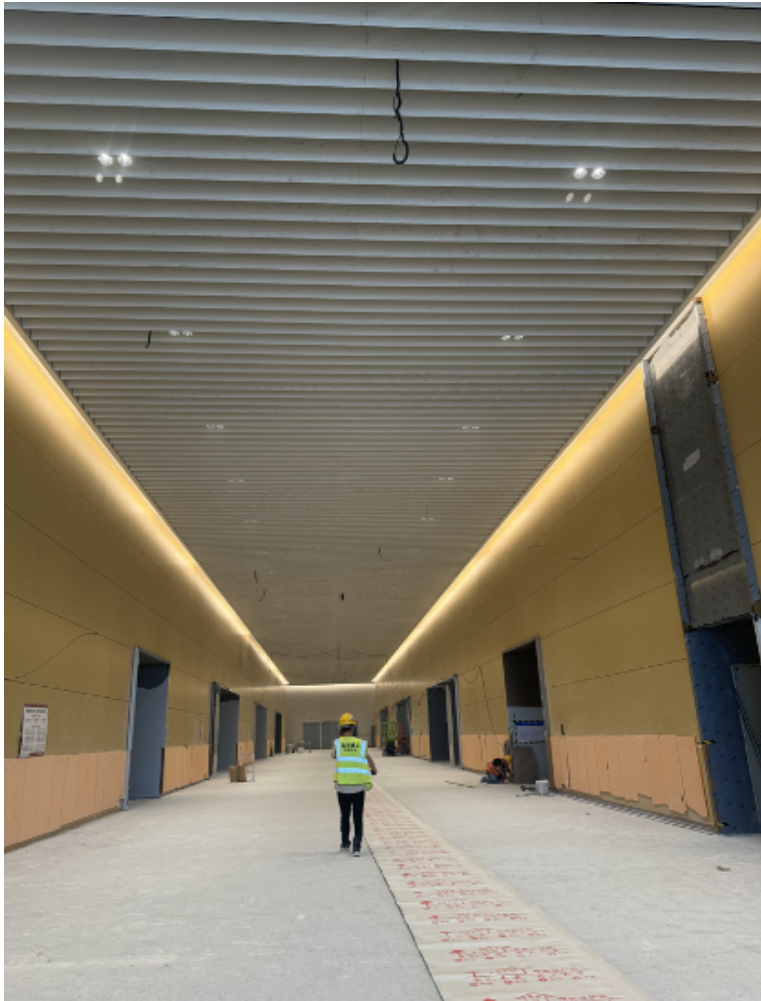
根据天花格栅定制灯具支架，定制了四种支架尺寸
