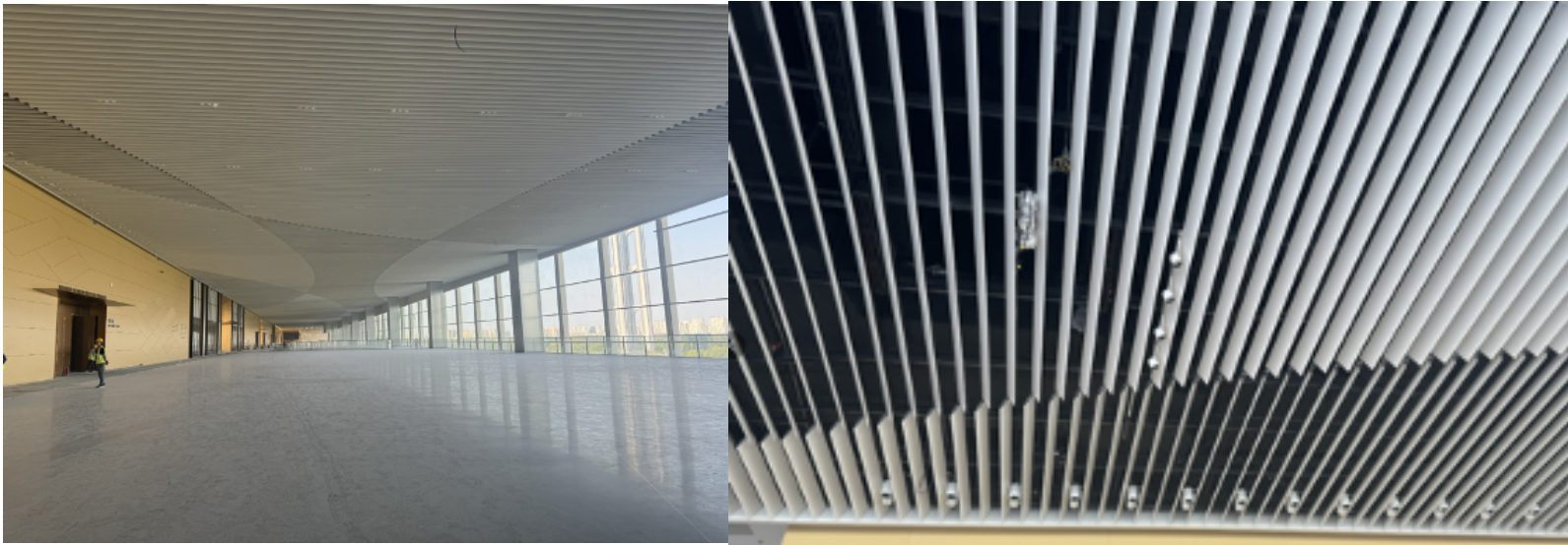
根据天花格栅定制灯具支架，定制了四种支架尺寸
