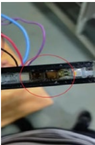
供电电压不一致
