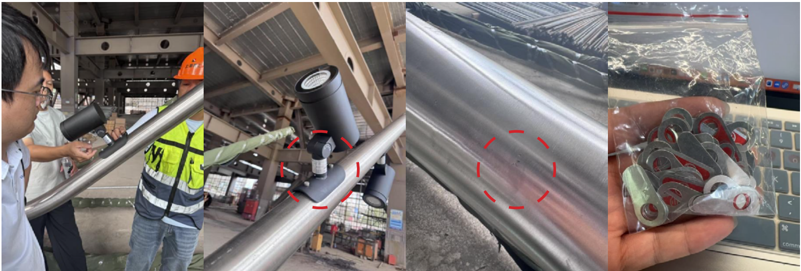
调试阶段：现场服务工程师配合园林施工方及智能控制方进行现场灯具调试；
